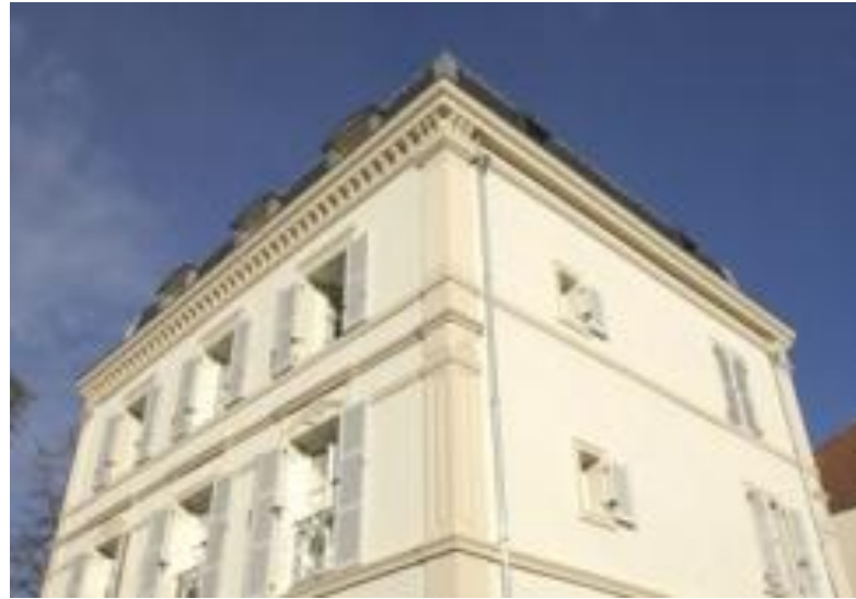
ITE StoTherm Classic avec Sto -Poly RT+ Sto Déco Profils -Architecte: Albin Puig
