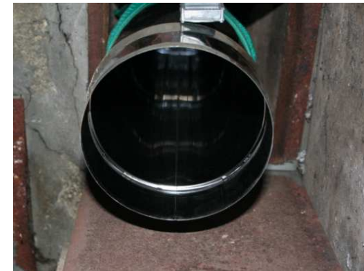
Le bas du conduit et le cône d'écoulement
