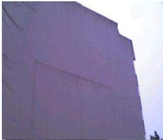
Pignon avec ravalement en bon état,
