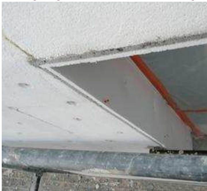
Détail du retour d'isolation en tableau des fenêtres
