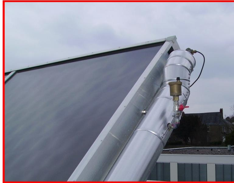
Erreur: purgeur non positionné au point le plus haut
