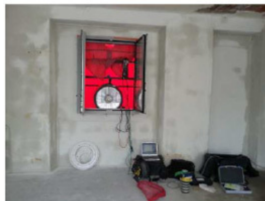
1 er test d'étanchéité à l'air
