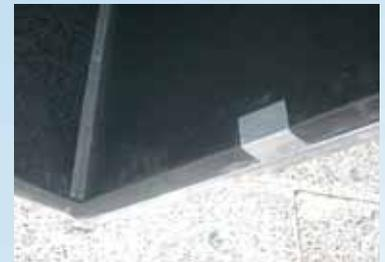
Patte d'arrêt soudée au conduit.
